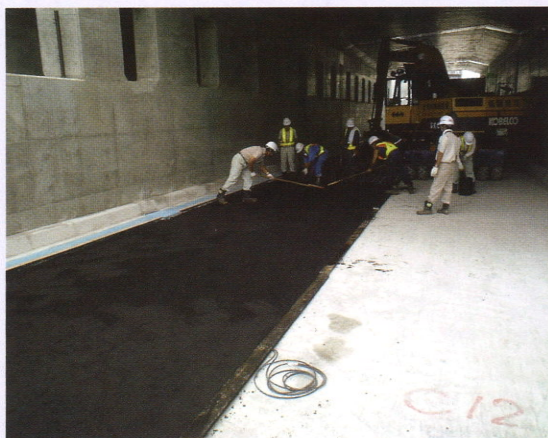
⑤ アスファルト舗装後
