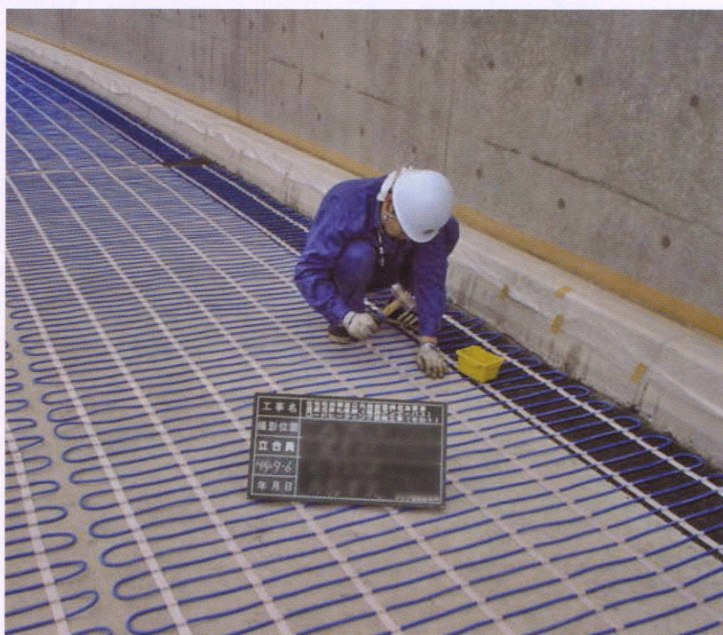
②ヒーティングケーブル敷設
