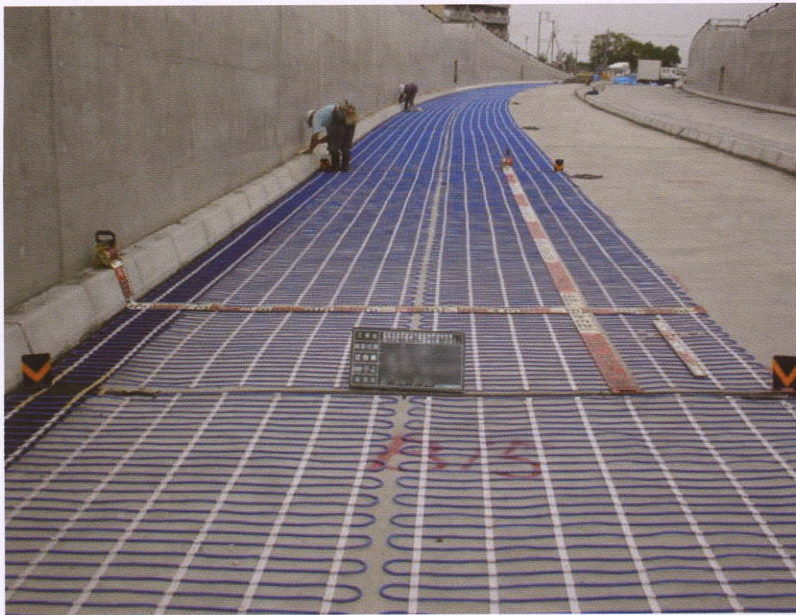
③ ヒーティングケーブル敷設後
