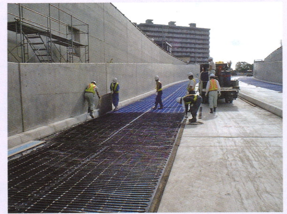
④ アスファルト舗装前
